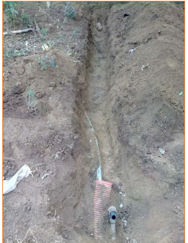
Foto 4. Obertura de rases per a la col·locació de servei nou.
