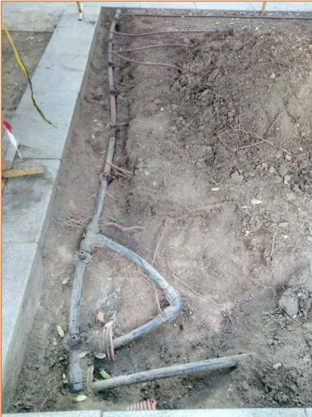
Foto 1. Obertura de rases per localitzar serveis actuals.
