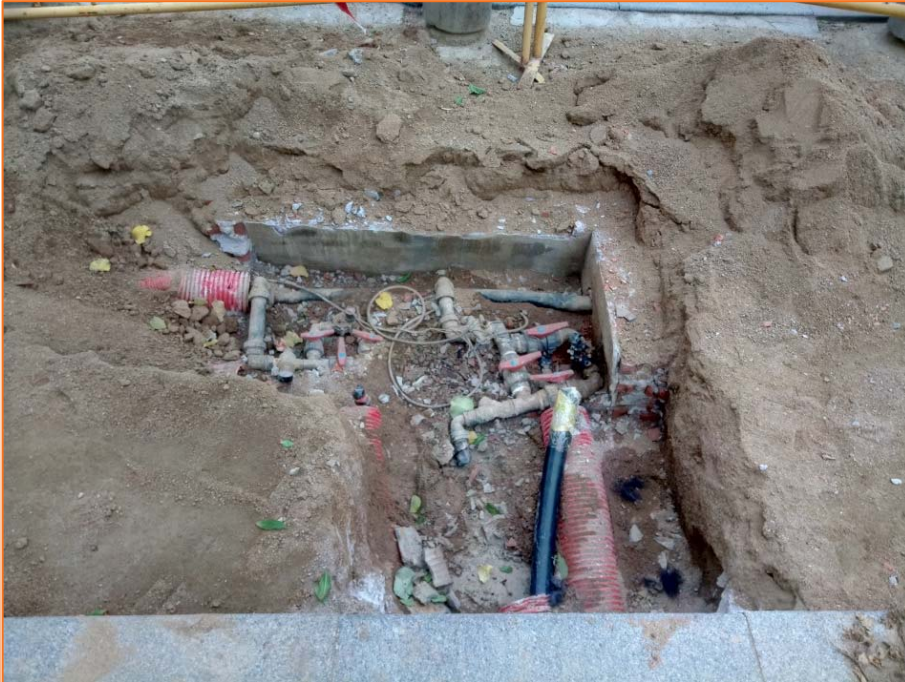
Foto 9. Rebaix per a la instal·lació d'una arqueta.
