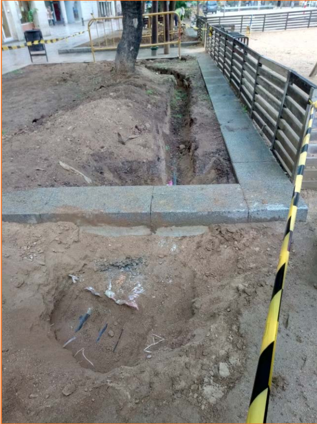
Foto 3. Obertura de rases per a la col·locació de servei nou.
