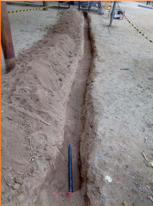
Foto 5. Obertura de rases per a la col·locació de servei nou.
