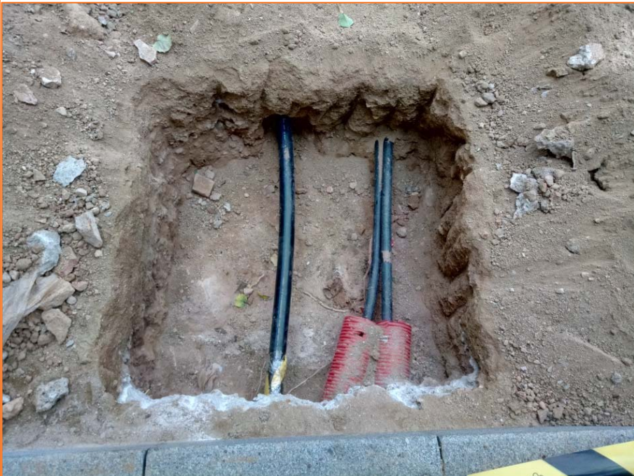
Foto 10. Rebaix per a la instal·lació d'una arqueta.
